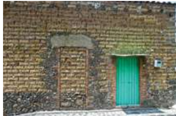
Modificación en las fachadas de una casa vernácula, barrio Santa Cruz, Tepoztlán, Morelos/Juan Antonio Siller
